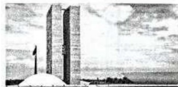
- Prédio do Congresso Nacional em construção. Brasília, no Distrito Federal 2015
